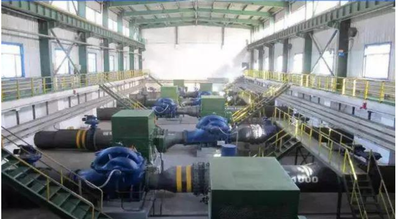
热电厂CCPP循环水泵房
